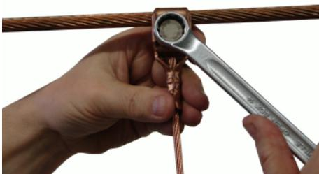
3. Befestigen der verpressten Seilhängerklemme am Tragseil. Anziehen der Schraube mit 25 Nm.
