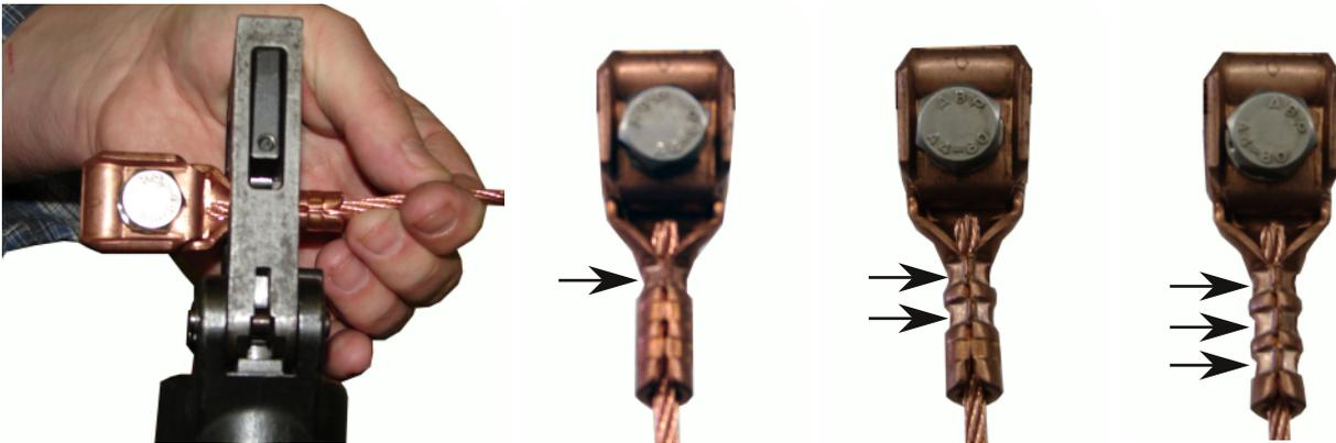
2. Provisorische Befestigung der verpressten Seilhängerklemme am Tragseil.
