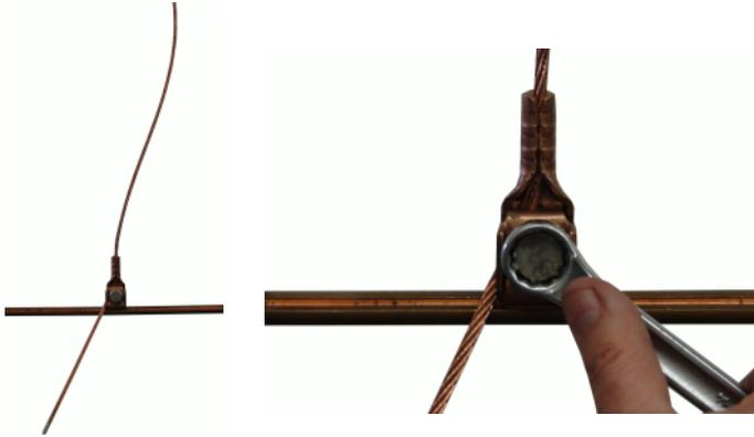
5. Definitive Einstellung der Fahrdrathöhe. Nach dem Lockern der Schraube die Fahrdrathöhe durch Zug am Seilende auf Soll-Position bringen.
