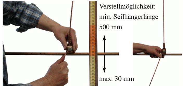
6. Definitive Befestigung der Seilhängerklemme am Fahrdraht. Anziehen der Schraube mit 25 Nm.
